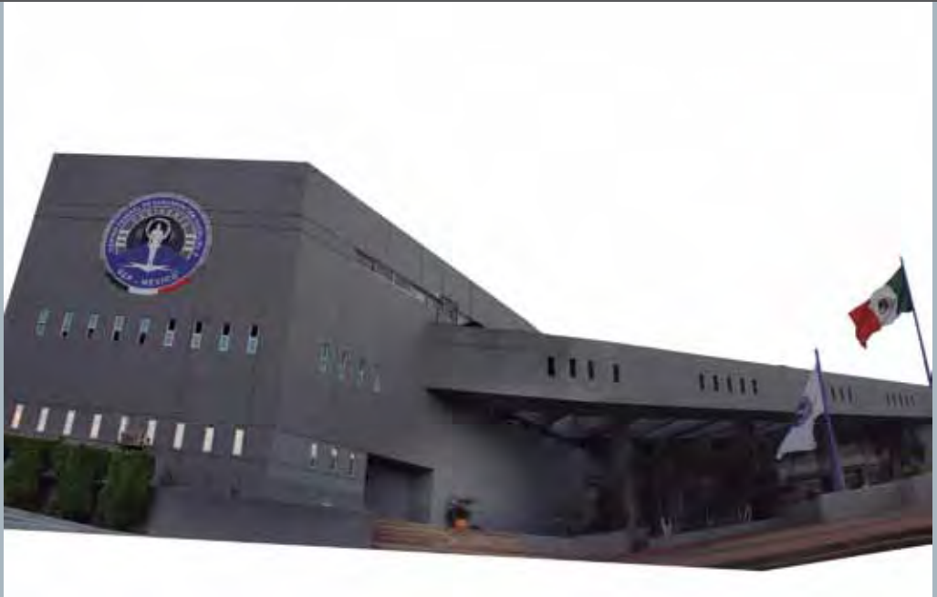
Centro Penitenciario Federal núm. 2, "Occidente" (Guadalajara).
